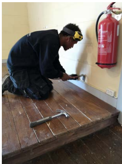
Tesfalem Araja er klar til å fjerne gamle lister. Foto: Helge Naustdal
