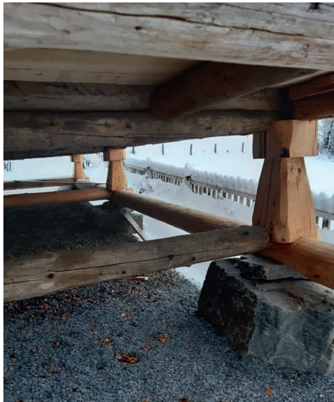
Nye stabbar under sørveggen.
